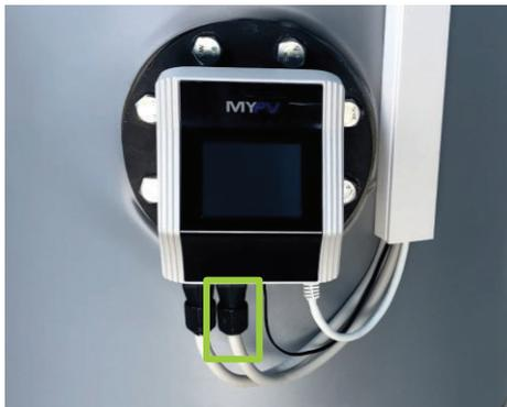
Anschließend die Zugentlastung mit der Befestigungsschraube (Torx TX10 3x8mm) am AUX-Relais (NO COM NC) der Elektronikeinheit anschließen.
